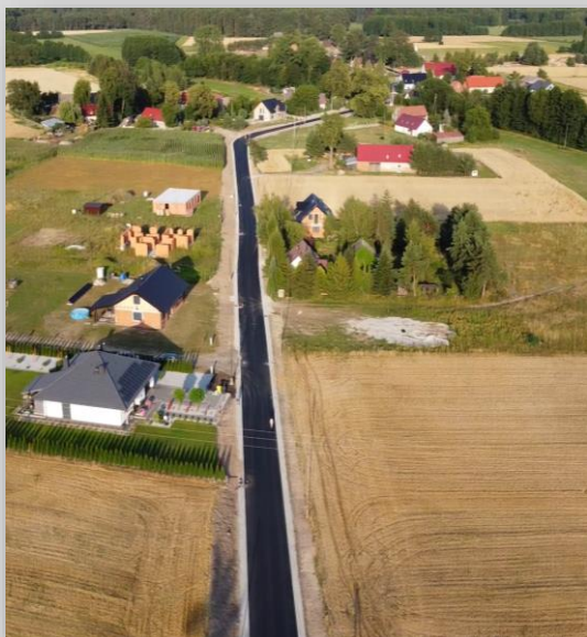
Budowa drogi w Nowych Smarchowicach
